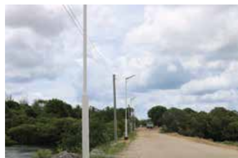
Solar Street lights sa Pinagpala Pier.
